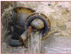
Der eingeklemmte Schwamm kann nur durch Abbruch entfernt werden.
